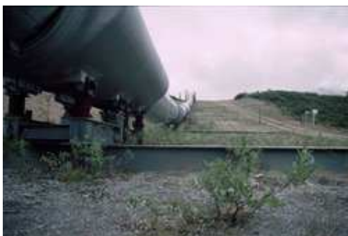
Pipeline auf Ständern
